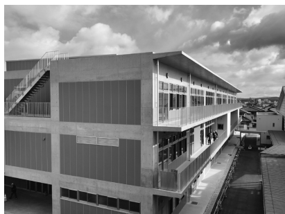
2025年1月 新中学校校舎完工（南西側から）
