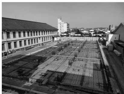
2024年3月 新中学校校舎基礎工事
